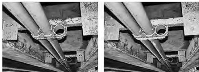
写真-8 画像 AI による損傷抽出例 (錆)
