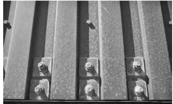
写真一七 高耐食めっき鋼板(3年経過時)
