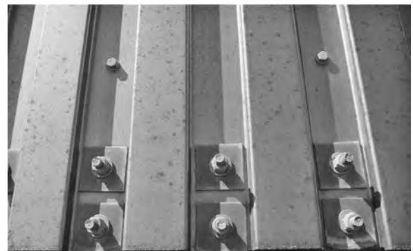
写真一八 ステンレス鋼板(3年経過時)
