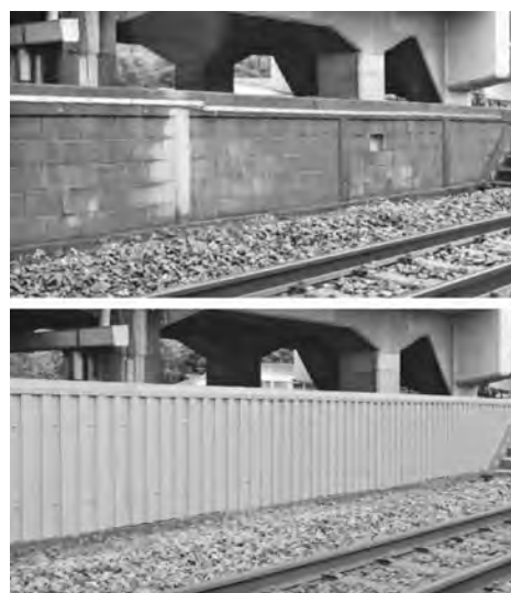
写真-1 本工法外観（上：施工前，下：施工後）
