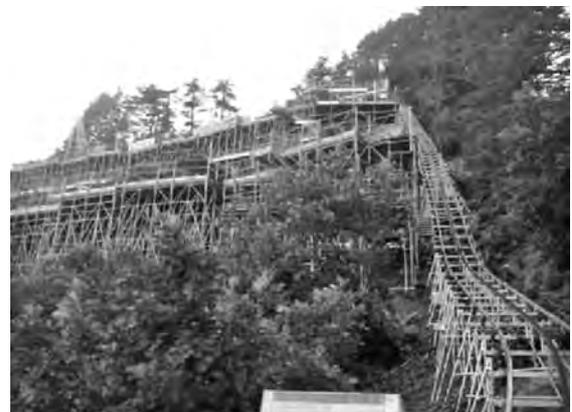
写真一8 作業構台上に資機材搬入
