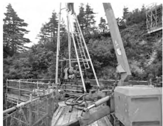
写真一9 ダウンザホールハンマの機材を搬入
