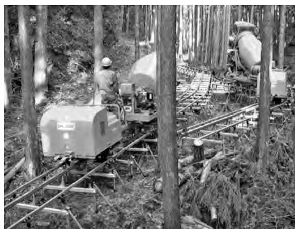
写真-5 1m<sup>3</sup>ミキサー台車
