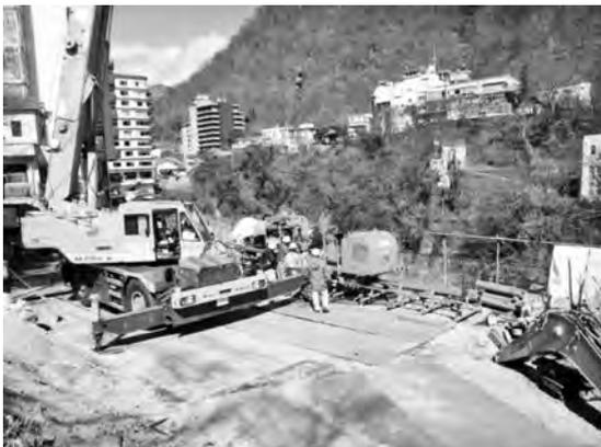
写真-15 0.45 m<sup>3</sup> バックホウを分解運搬
