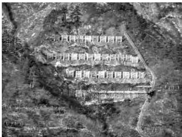
写真-12 雪崩柵設置後、作業構台を撤去中
