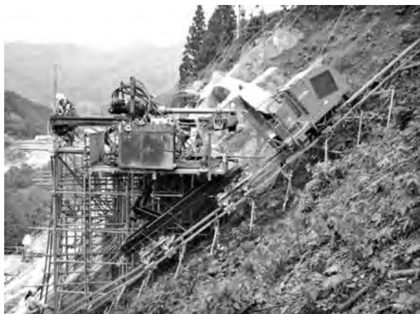
写真-2 4t積載フラットデッキダンプ台車
