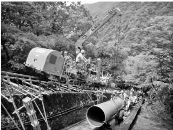
写真一6 2t積載クレーン台車
