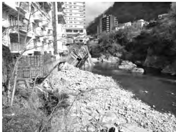
写真-13 損壊した護岸(復旧前)
