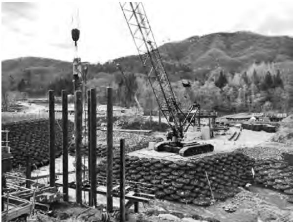
写真—6 プレボーリング状況
