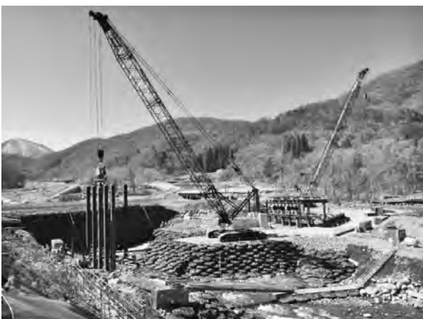
写真—7 鋼管杭打設状況
