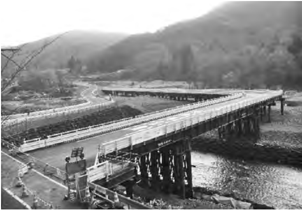
写真一 10 仮橋完了全景（起点側）
