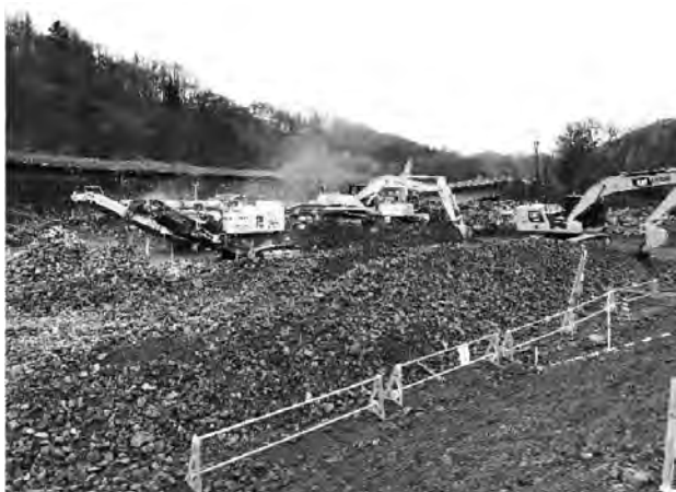
写真—4 自走式破碎機クラッシング状況
