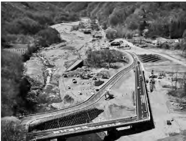
写真一 11 仮橋完了全景（ドローン撮影）
