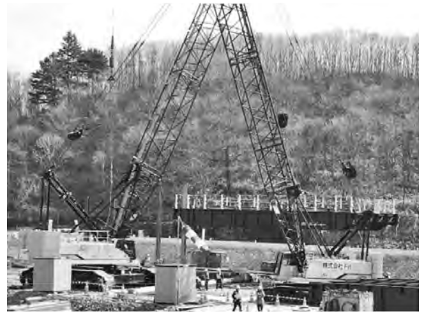
写真—8 一括架設状況
