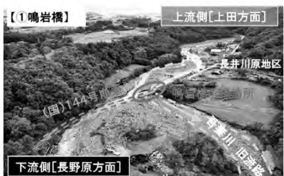
写真—1 被災状況 1)
