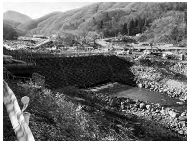
写真—5 緊急迂回路施工完了
