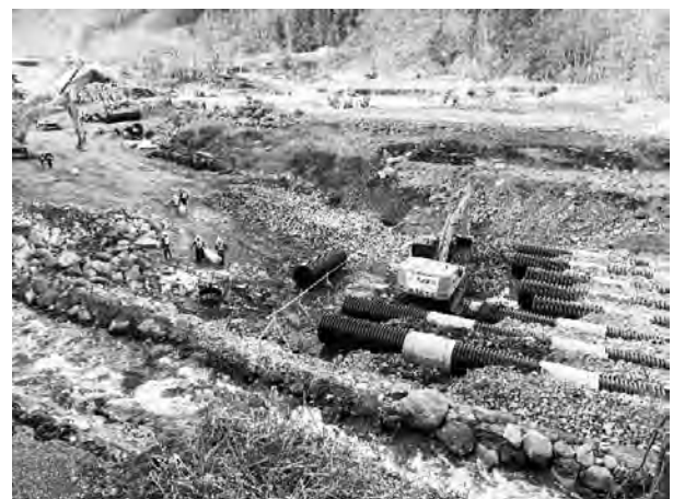
写真一 3 コルゲートパイプ設置状況
