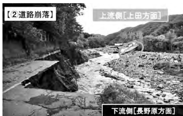
写真—2 被災状況 1)
