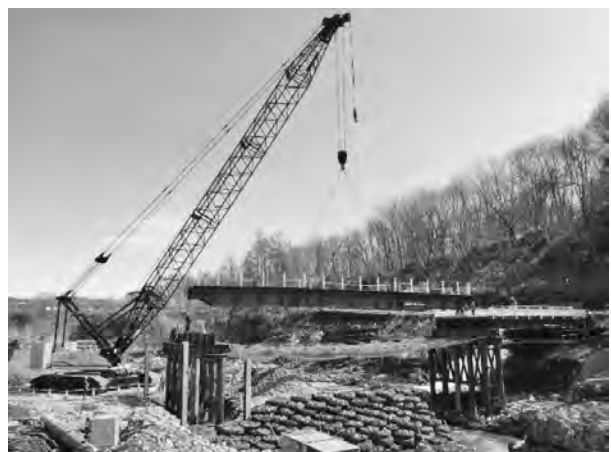
写真—9 分割架設状況
