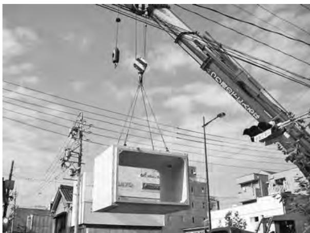
写真-1 PCa製品クレーン施工状況
