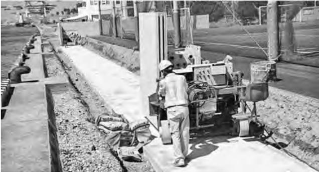
写真-12 パラペット施工状況
