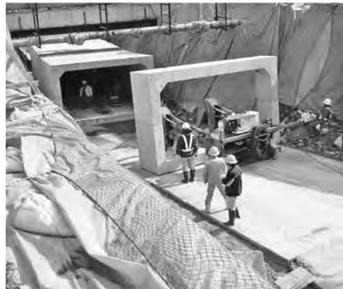
写真-8 縦断勾配部での施工状況
