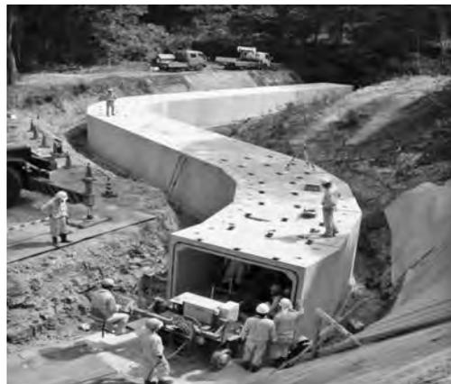
写真-7 曲線部での施工状況
