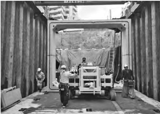
写真一10 2分割ボックスカルバート施工状況
