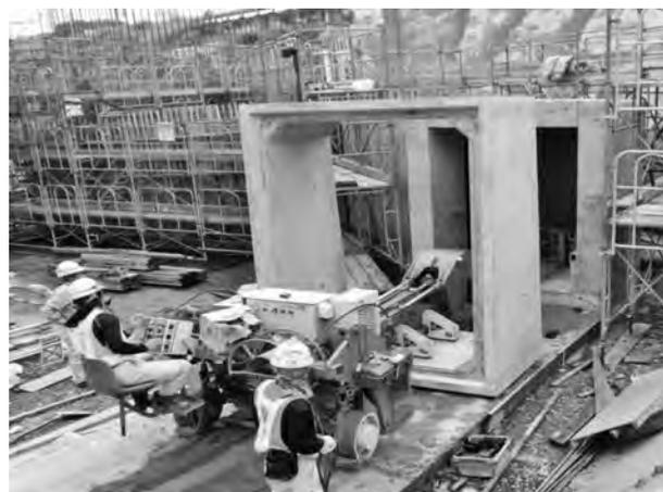
写真-2 搬送据付装置での施工状況
