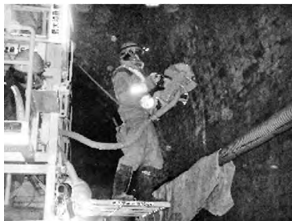
写真一3 レンガ切断工
