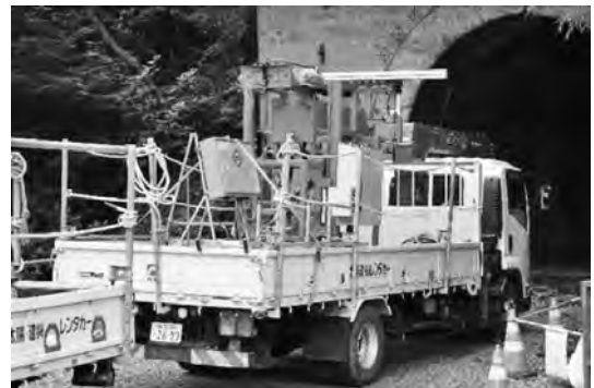
写真-7 トンネル搬入時
