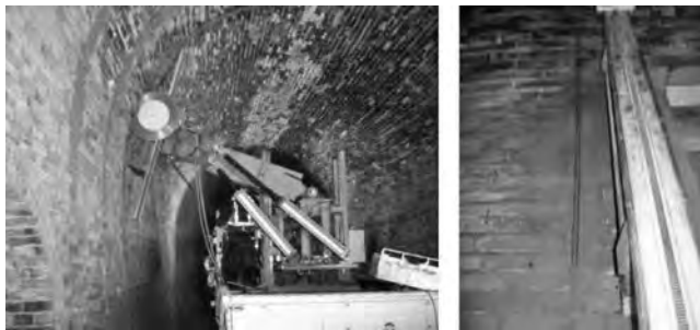
写真—8 作業状況
