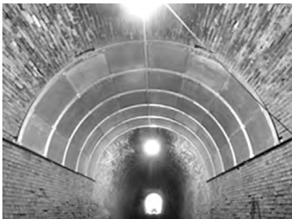
写真一1 T3パネル工法設置事例1
