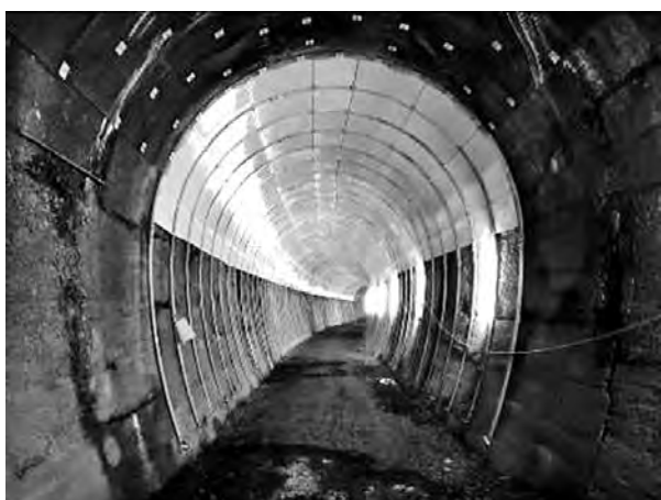
写真一2 T3パネル工法設置事例2
