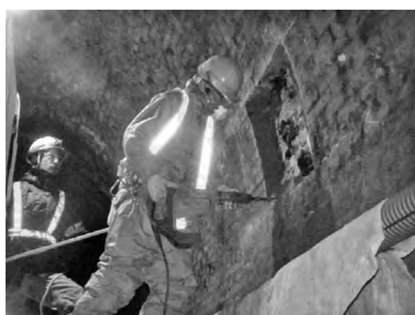
写真一4 レンガはつり工
