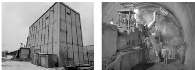
図-1 コンクリート製造設備および吹付けコンクリート施工状況
