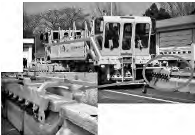
写真一 2 専用作業車およびコンベア部
