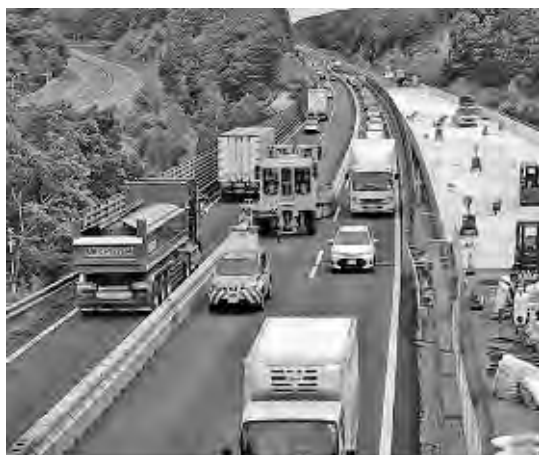
写真-7 交通規制状況（道央道）
