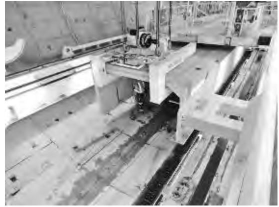
写真—9 カルバート設置状況
