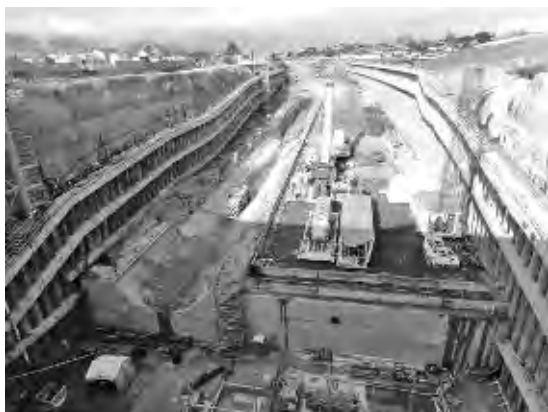
写真一三 南開削部発進部
