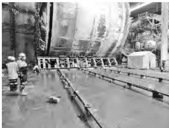
写真一五 シールド機回転途中
