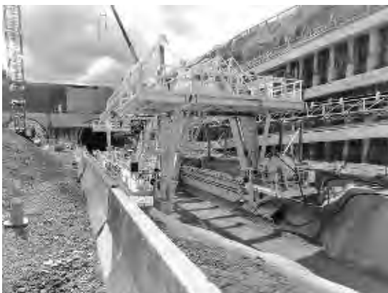
写真—8 カルバート設置台車
