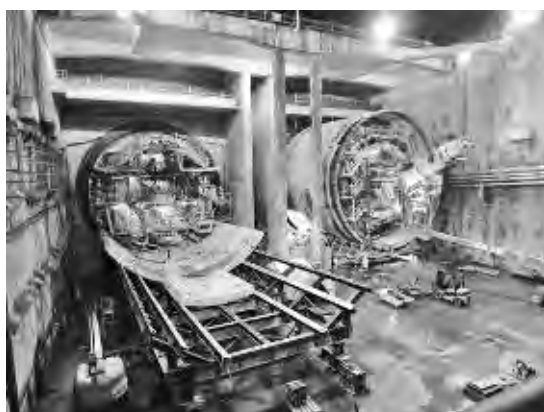
写真一六 シールド機回転後
