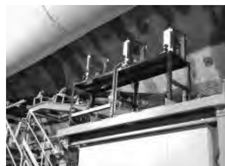
写真一4 映像・制御信号通信システム (坑内固定ユニット)
