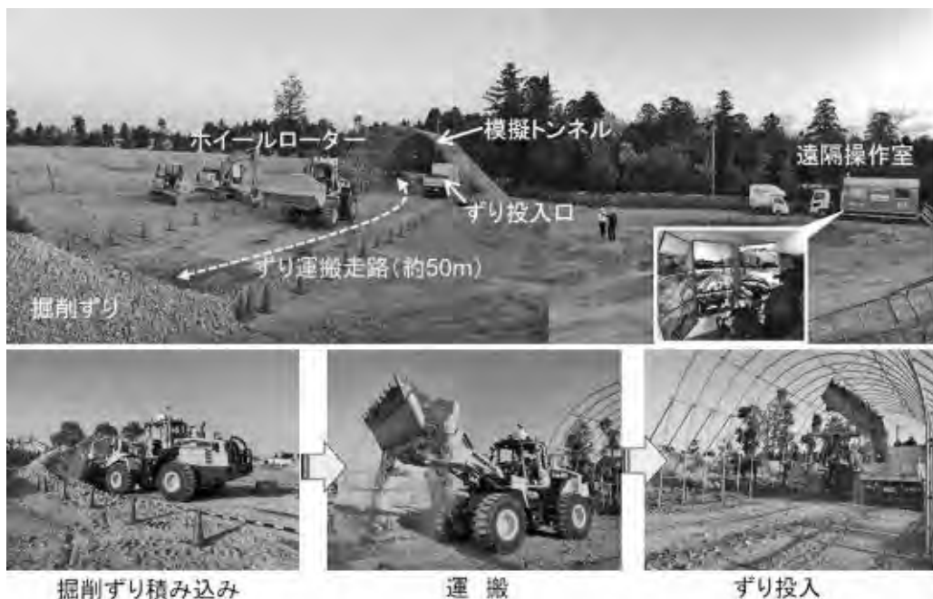
写真-7 屋外ヤードにおける遠隔操作実験状況
