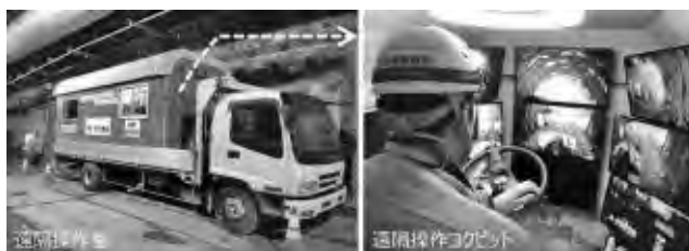
写真二 遠隔操作室および運転コクピット
