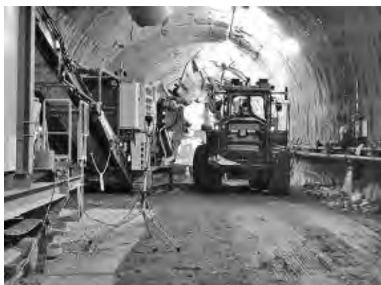
写真-8 トンネル坑内における遠隔操作実験状況
