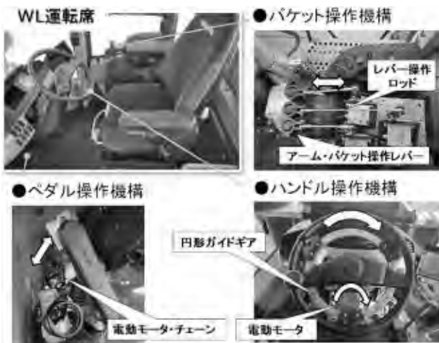
写真一 遠隔運転制御装置
