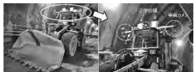
写真一3 映像・制御信号通信システム (WL 搭載ユニット)
