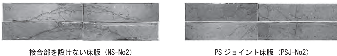
図一 10 試験体内部ひび割れ性状
