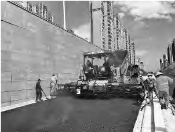
写真一六 市街地補修施工での2車線同時施工
