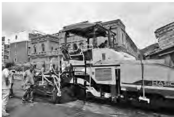
写真-9 市街地補修施工でのビッグスキーを使用した舗装
