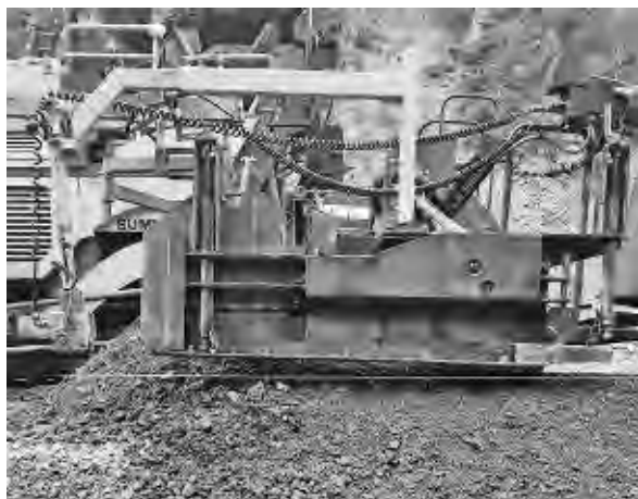
写真—3 舗装厚 30 cm の基層路盤材施工
