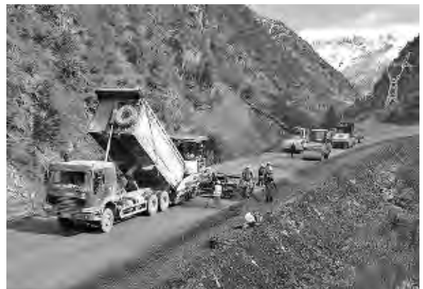
写真-2 新設道路での 2 車線基層路盤材施工
