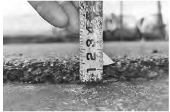
写真一八 無切削オーバーレイ15mm薄層舗装
