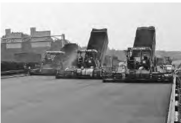
写真一七 複数台の伸縮機を用いた高速道路補修施工
