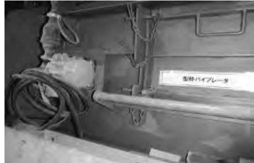
写真一8 型枠バイブレータ
