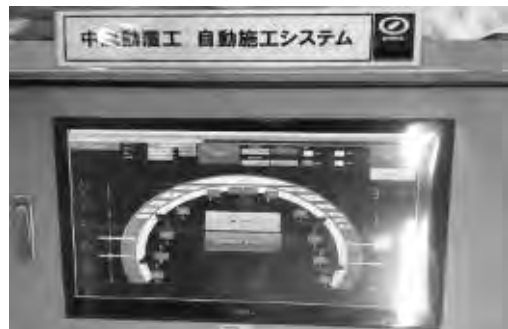
写真一11 打込み締固めモニター (断面)
