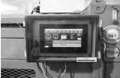
写真一4 ポンプ圧送デジタルデータパネル
