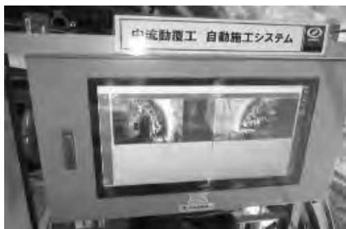
写真-13 自動施工システム制御盤
