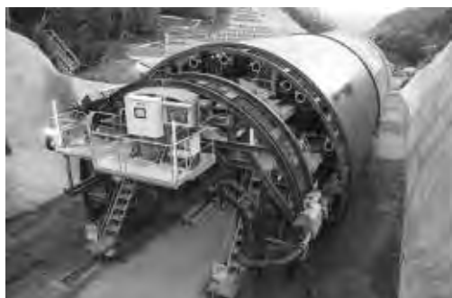
写真—2 マニピュレータ方式配管切替え装置
