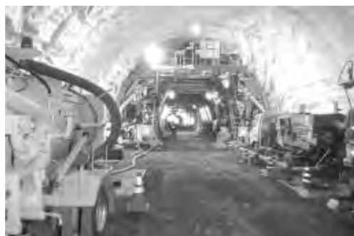
写真—3 覆工コンクリート自動施工状況
