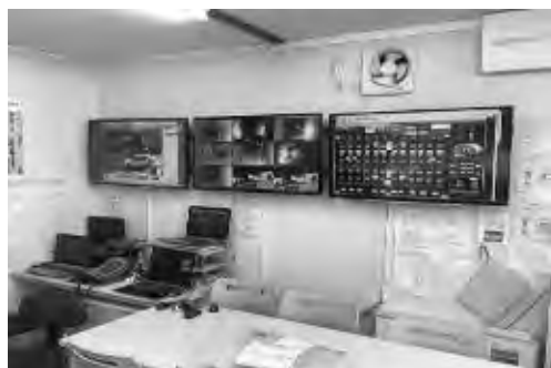
写真-15 統合管理モニター (事務所)
