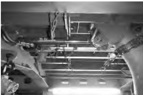
写真一6 シャッターバルブ付き打設孔
