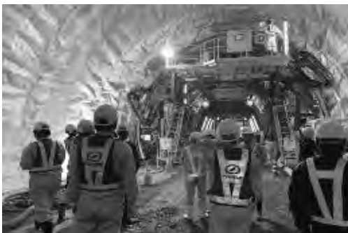
写真—18 現地立会状況
