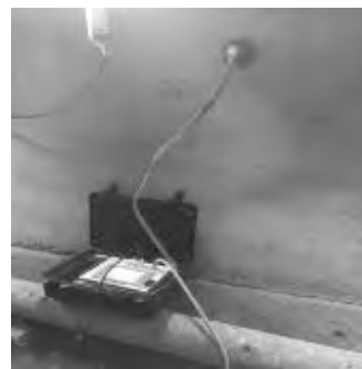
写真—23 透気試験状況
