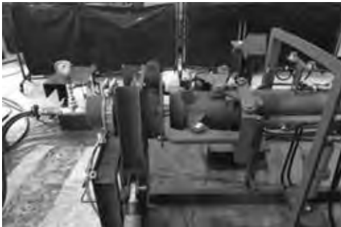
写真—17 モックアップ試験（配管脱着）
