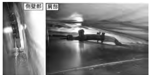
図-2 ホース伸縮連続打設システムを用いた打設状況
