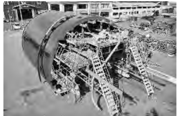
写真-1 ホース伸縮連続打設システム全景
