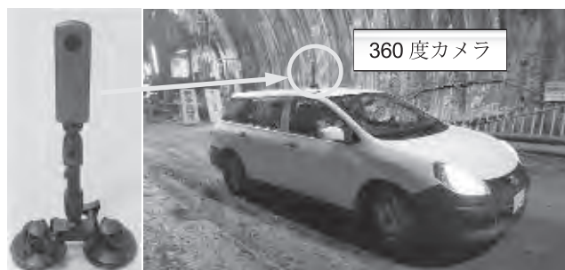
写真—1 トンネルリモートビューによる映像取得状況
