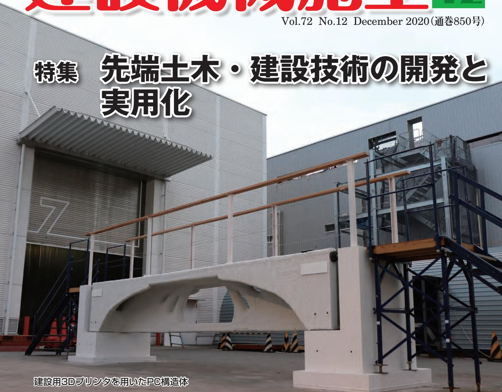
建設用3Dプリンタを用いたPC構造体
