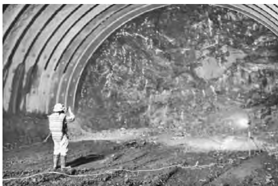
写真-1 切羽写真撮影の様子
