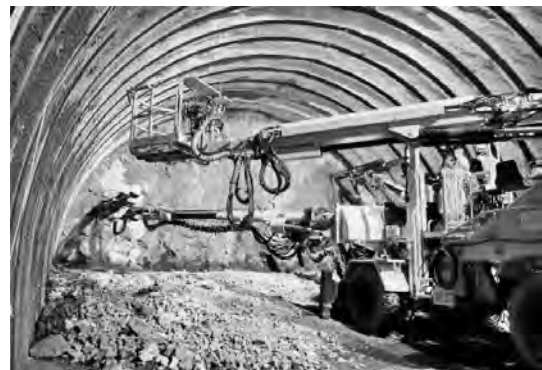
写真-6 ドリルジャンボの穿孔作業状況
