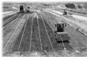
図-1 転圧プロセスを自動化した一貫した転圧作業
