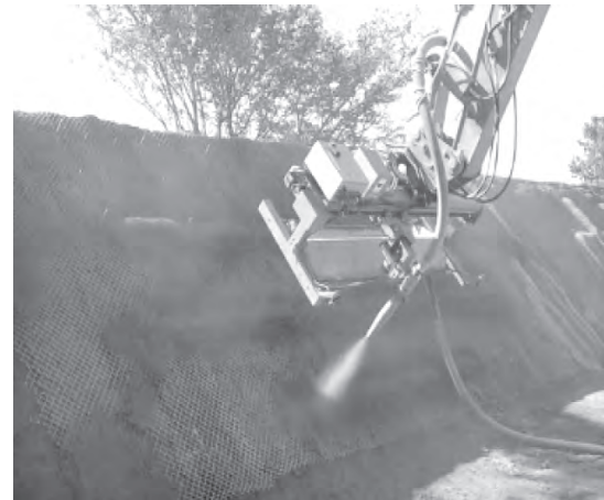
写真一 4 横枠吹付け状況
