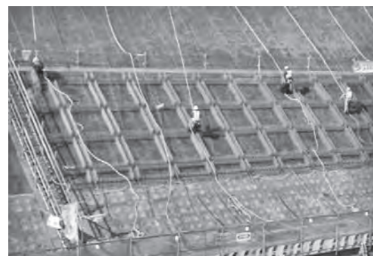
写真—2 鉄筋・型枠組立作業
