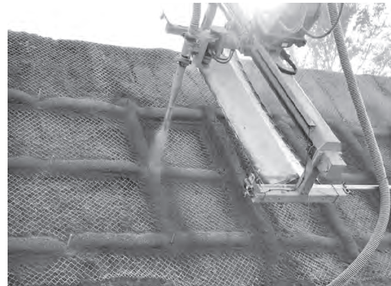
写真一 5 縦枠吹付け状況
