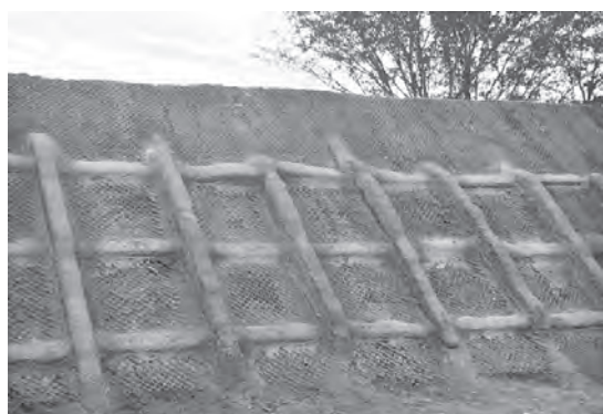
写真一6 格子柵吹付け完了
