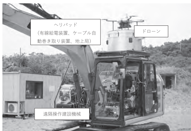
写真一1 システム外観
