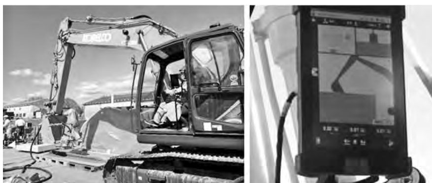
写真一4 水平吹き状況とICT建機コントロールボックスの画面
