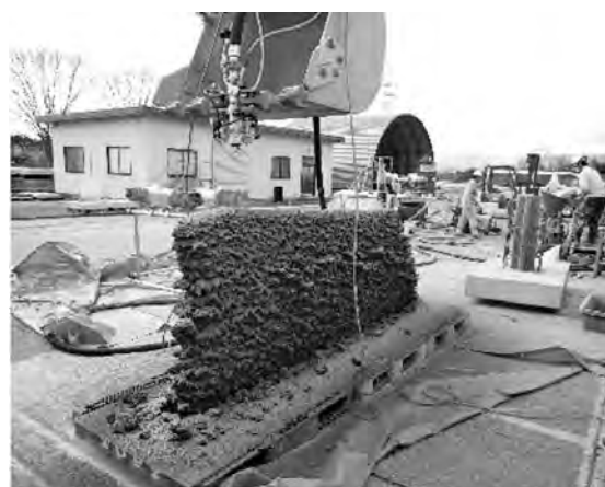
写真一5 壁状部材（鉛直吹き）の造形状況
