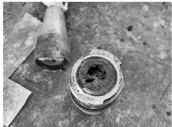
写真-1 配管の詰り状況
