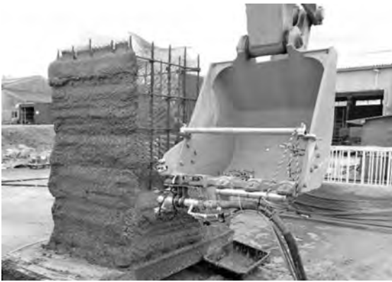
写真—6 埋設型枠（水平吹き）の造形状況
