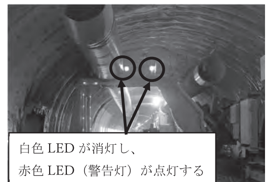
写真-4 赤色 LED 照明点灯モード
