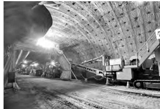
写真-3 照明架台と白色 LED 照明
