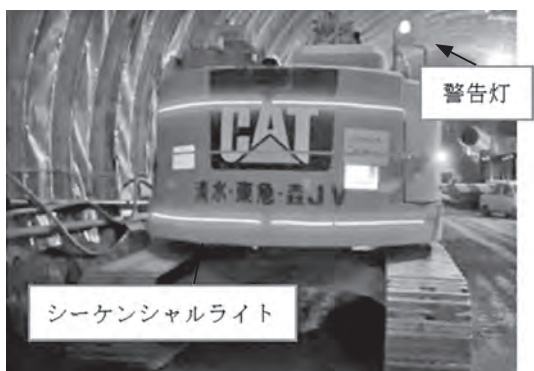
写真一七 警告灯点灯状況
