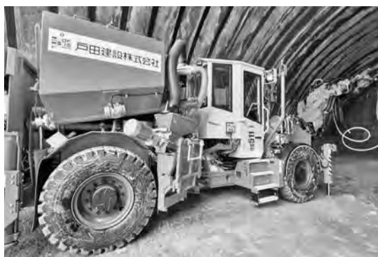
写真二 モルタル充填設備（施工時）
