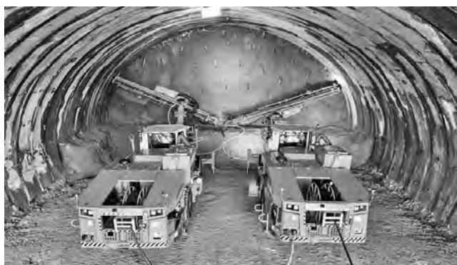
写真一 4 ロックボルト施工状況
