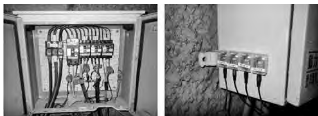
図-2 電力センサー取付け状況
