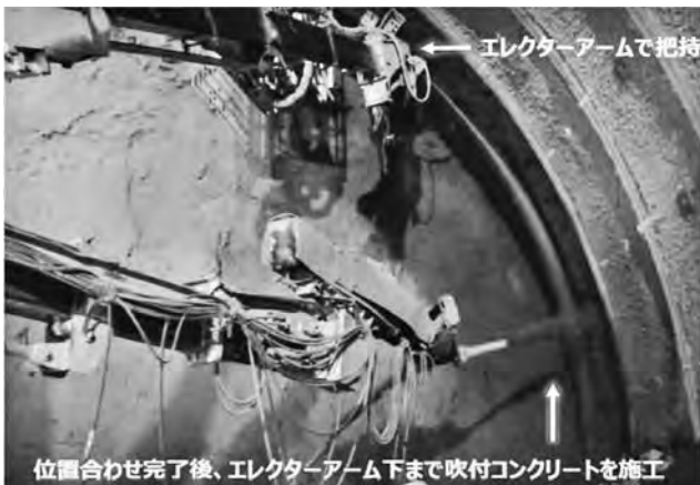
写真—13 右側鋼製支保工脚部固定状況
