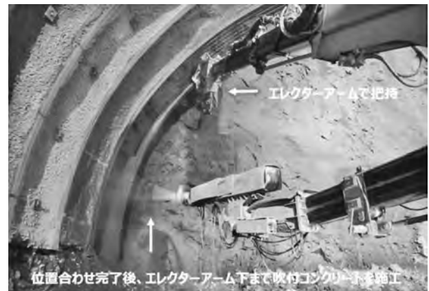
写真—15 左側鋼製支保工脚部固定状況
