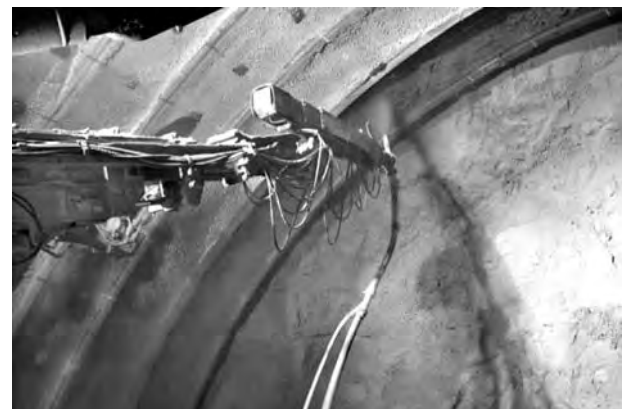
写真—16 天端部二次吹付けコンクリート状況
