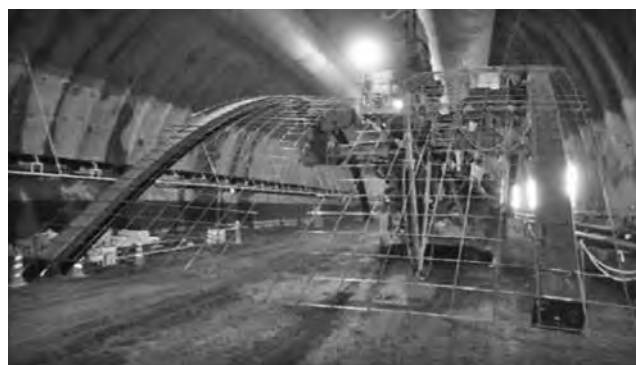
写真—11 溶接金網取付完了
