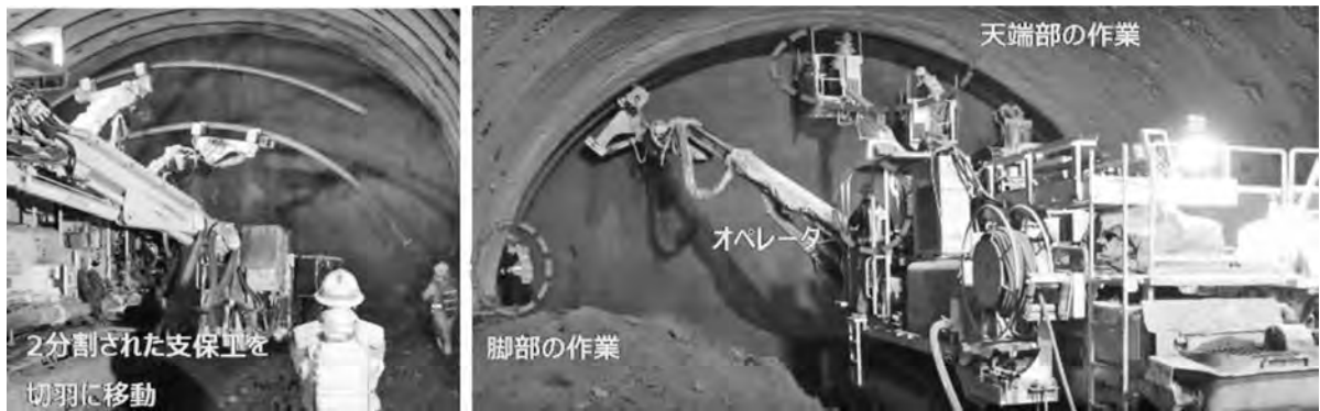
写真一 1 現行のエレクター搭載型吹付機による施工方法
