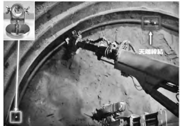
写真—14 左側鋼製支保工位置合わせ状況
