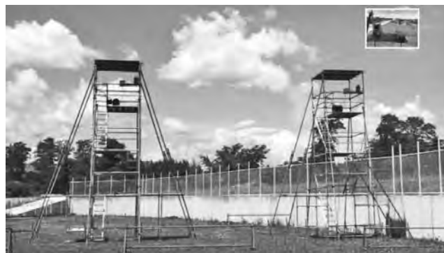
写真—10 自動追尾型トータルステーション架台
