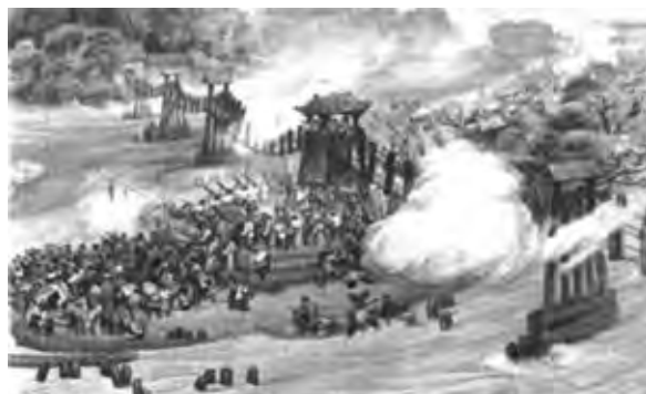
図-1 魚嘴の建設
