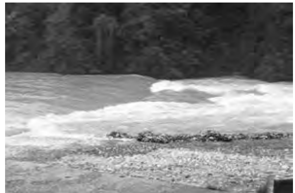
写真一 4 内江と飛沙堰 (出水期には、内江の水が手前の飛沙堰を越えて外江へ流れる)
