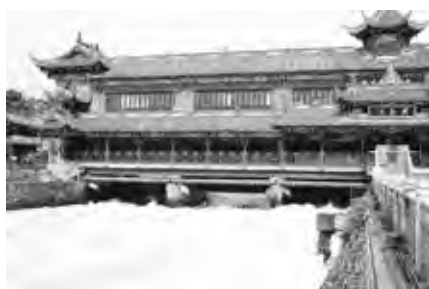
写真一六 被災直後の天府源大橋 (2008年6月)
