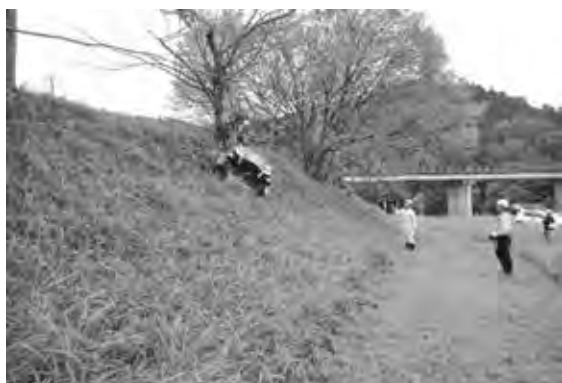
写真一8 現場試行状況
