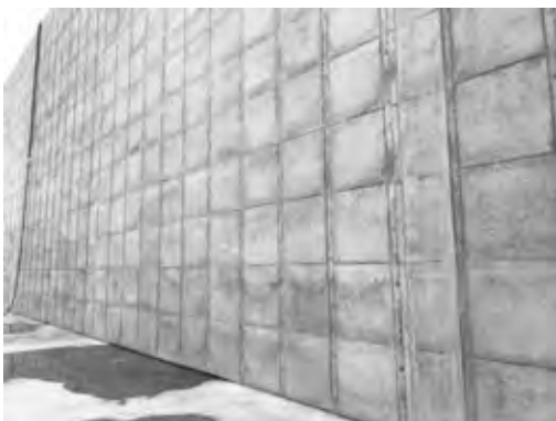
写真三 コンクリート仕上がり面 (縦スリット)
