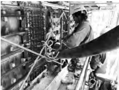
写真二 コンクリート打設状況 (圧送ホースの水平挿入)
