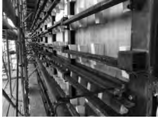
写真一 本工法 型枠構造
