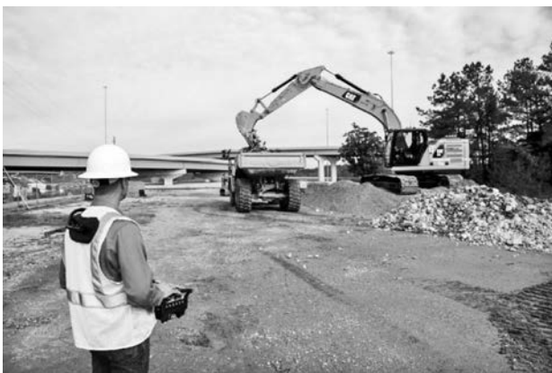
写真一 1 遠隔操作状況
