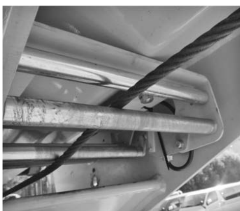
写真二 フック接地検出装置
