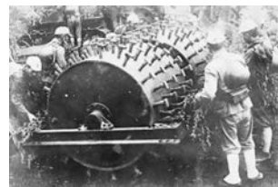
写真-43 設営隊の棘付点圧機
