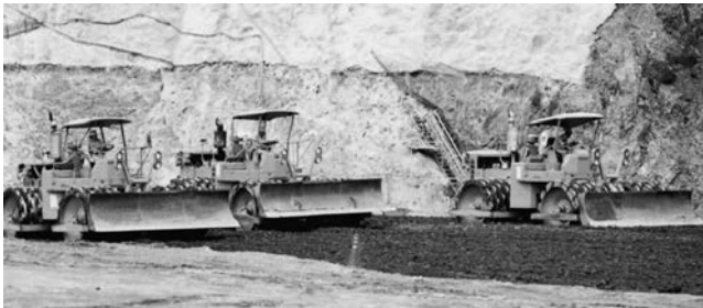
写真—56 寒河江ダムの 825
