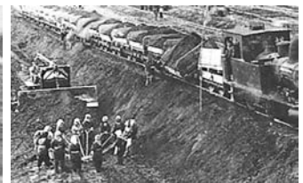
写真-44 石蛸による突固め
