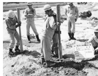
写真—61 凹部の杵突き
