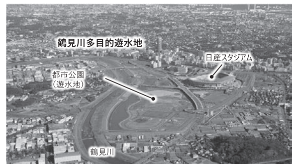
図一 鶴見川多目的遊水池
