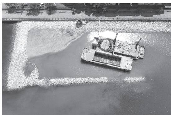
写真一八 狭隘条件による片押施工
