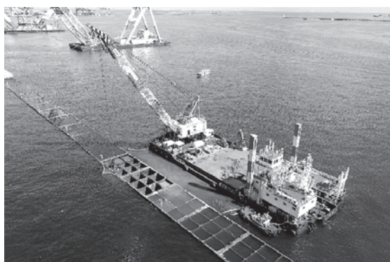
写真一四 養浜砂（中詰砂）撤去
