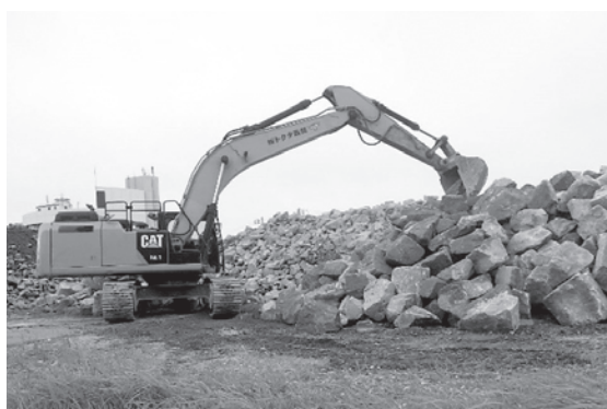
写真一五 仮置ヤードでの材料選別
