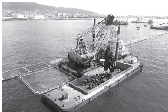
写真一三 基礎捨石（流用石材）撤去
