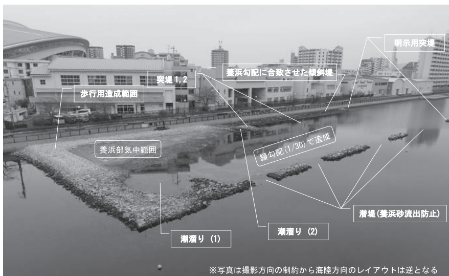
図一六 兵庫運河干潟完成全景
