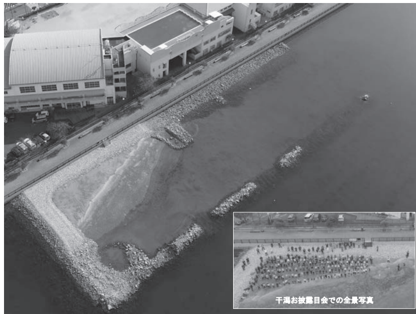
写真一 10 完成した兵庫運河干潟の全景<干潮時>
