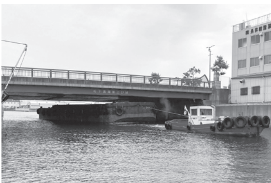
写真一 航行制限のある橋梁通過状況
