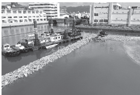
写真一七 流用材投入・外縁部傾斜堤構築
