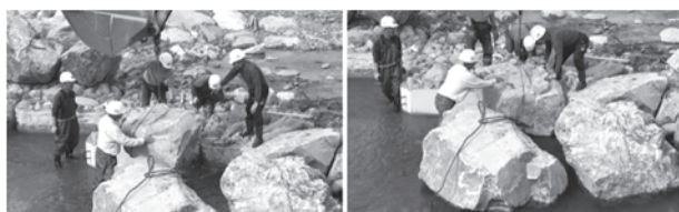
写真-3 石工の作業風景
