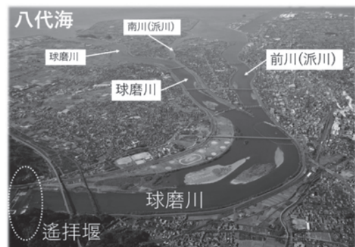
図—2 遙拝堰より下流付近
