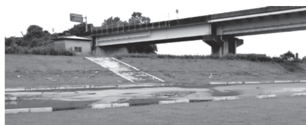
写真-5 水位の痕跡 (2020.7.15撮影)
