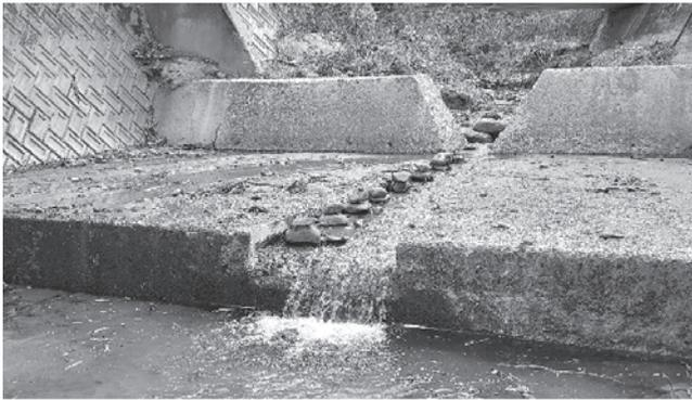
図一 4 切欠き魚道の完成
