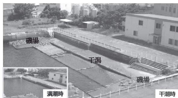
写真—1 完成した生物共生護岸『潮彩の渚』
