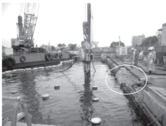
写真—3 既設杭引き作業の状況
