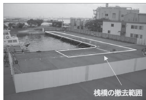
写真—2 施工前の様子
