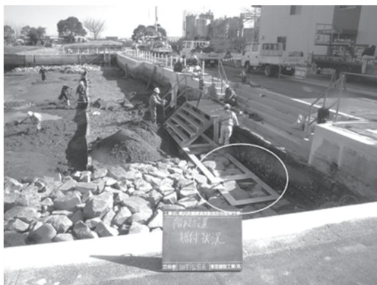
写真—4 干潟・磯場の造成と鋼製階段の設置
