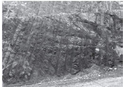
写真一七 法面仕上がり状況(B工法)
