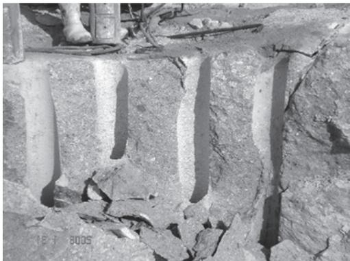
B 岩盤法面景観工法「油圧式割岩装置(V4)」
