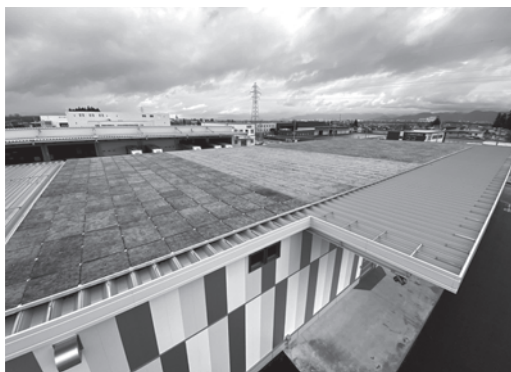
写真—2 食品倉庫コケボード施工
