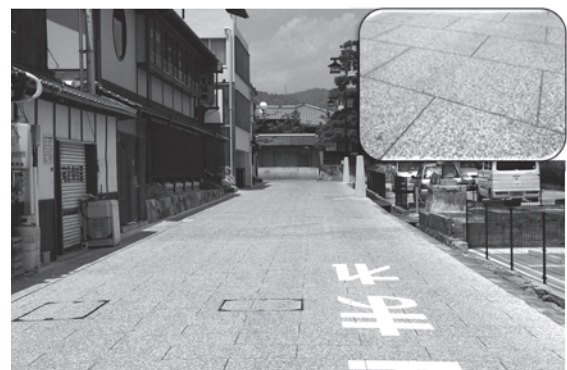
写真—2 疑似平板風舗装の施工例
