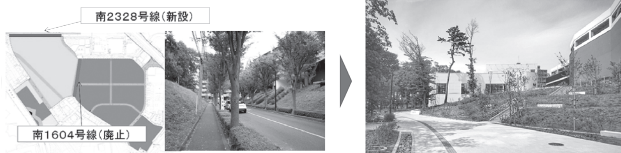
図一2 都市基盤の再配置 (左：道路再配置の概要と、廃止前の道路の様子 ⇒ 右：まちびらき後)
