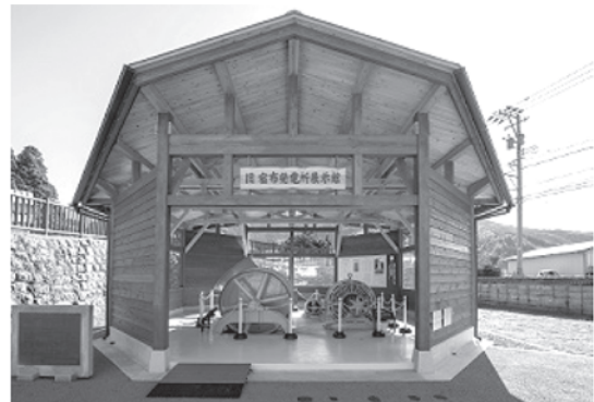
写真二 展示館の水車・発電機設備
