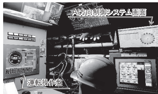
図-2 システム運用状況
