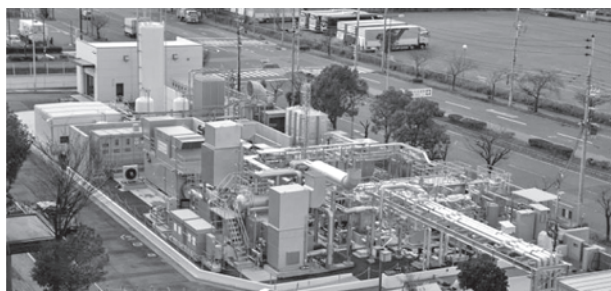
写真－1 神戸ポートアイランドの実証プラント（川崎重工業提供）
