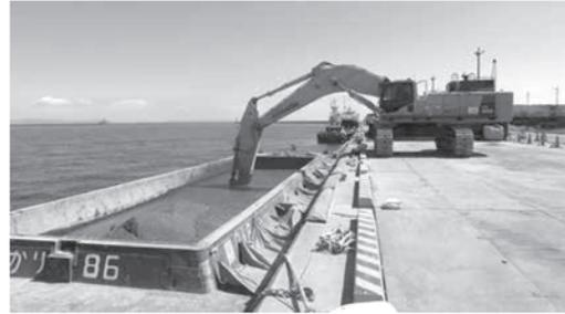
写真-1 バックホウ混合の施工状況
