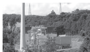
吾妻木質バイオマス発電所 (群馬県吾妻郡)
