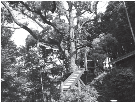
写真—3 土台にかけた木橋と床用の桁
