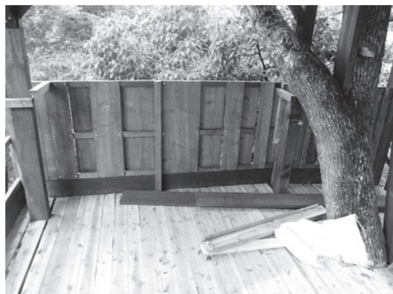
写真—5 完成した腰壁
