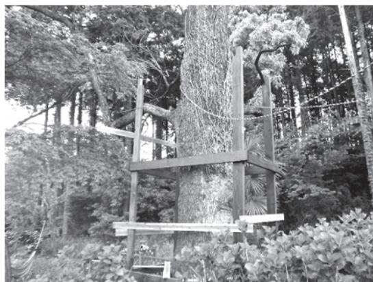
写真-2 楠木と土台が一体
