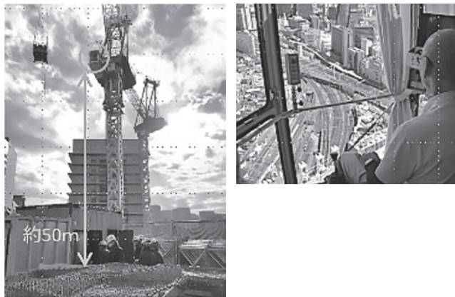
写真—4 タワークレーンオペレータの執務環境
