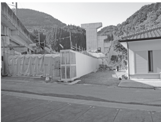
写真—13 現場出入り口の防音対策（閉めた状態）
