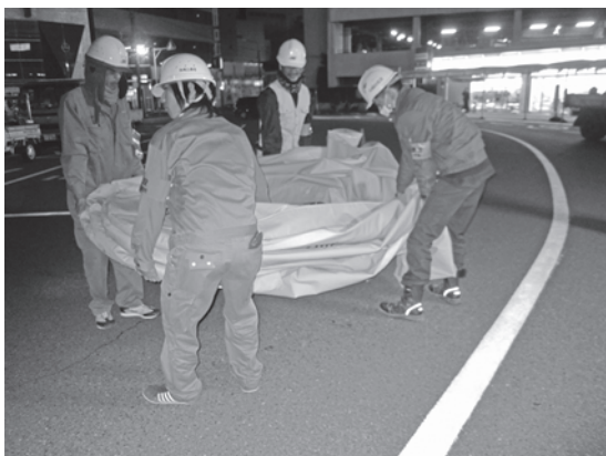
写真一九 人力によるトラックからの荷降ろし
