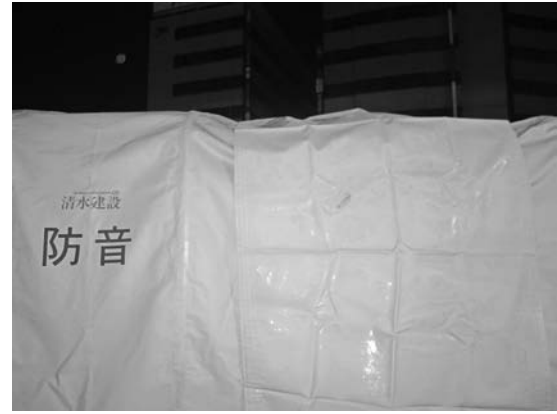
写真-6 ユニット間で隙間がない連結状態
