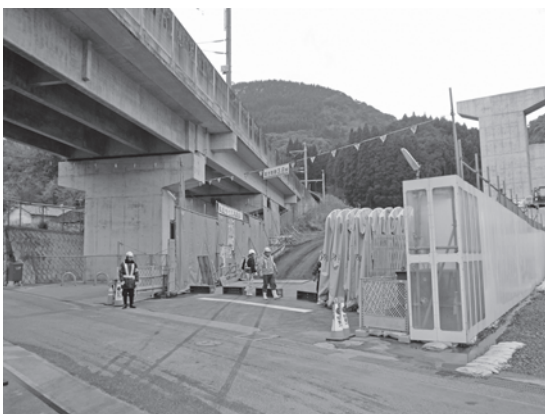
写真—14 現場出入り口の防音対策（開けた状態）
