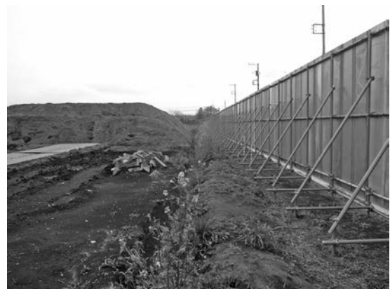
写真—1 従来の防音壁の例（単管の骨組に万能鋼板）
