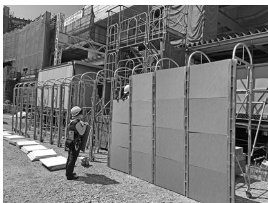
写真—18 本装置（紙タイプ）へのパネルの取付状況
