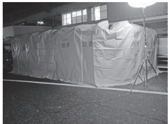
写真一二 コの字での使用事例 (外側)
