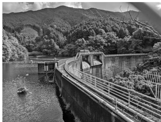
写真—3 アーチ式の須恵ダム(糟屋郡宇美町)
