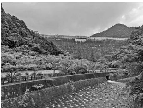
写真—1 最初に訪れた曲淵ダム(福岡市早良区)
