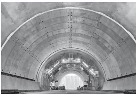
図-5 実証実験後の覆工
