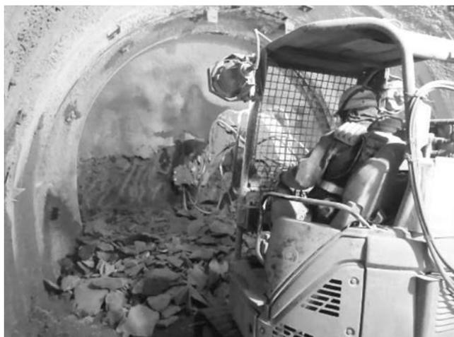
写真-11 ブレーカによる掘削状況
