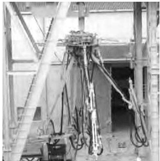
写真一2 発破掘削用シャフトジャンボ
