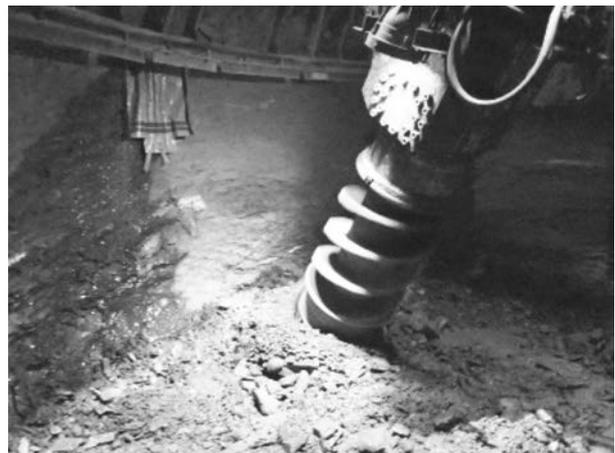
写真—5 自由断面掘削機による掘削状況（換気立坑）
