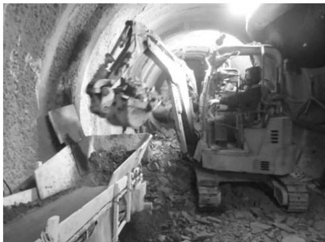
写真-12 ベルコンへのズリ積み込み状況
